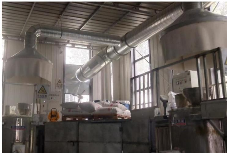
图 3-1 本项目混料间内集气罩及软帘设置情况照片
