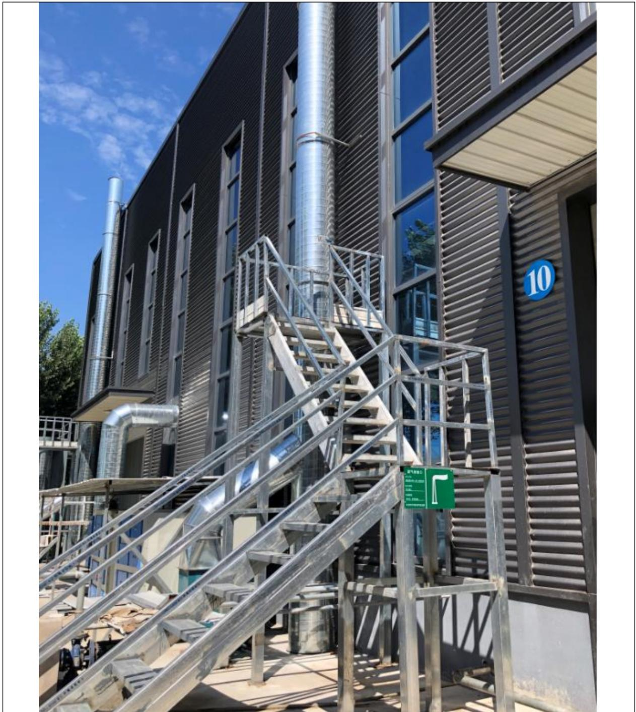
图 3-4 二级活性炭吸附装置及排气筒 P<sub>2</sub> 照片
