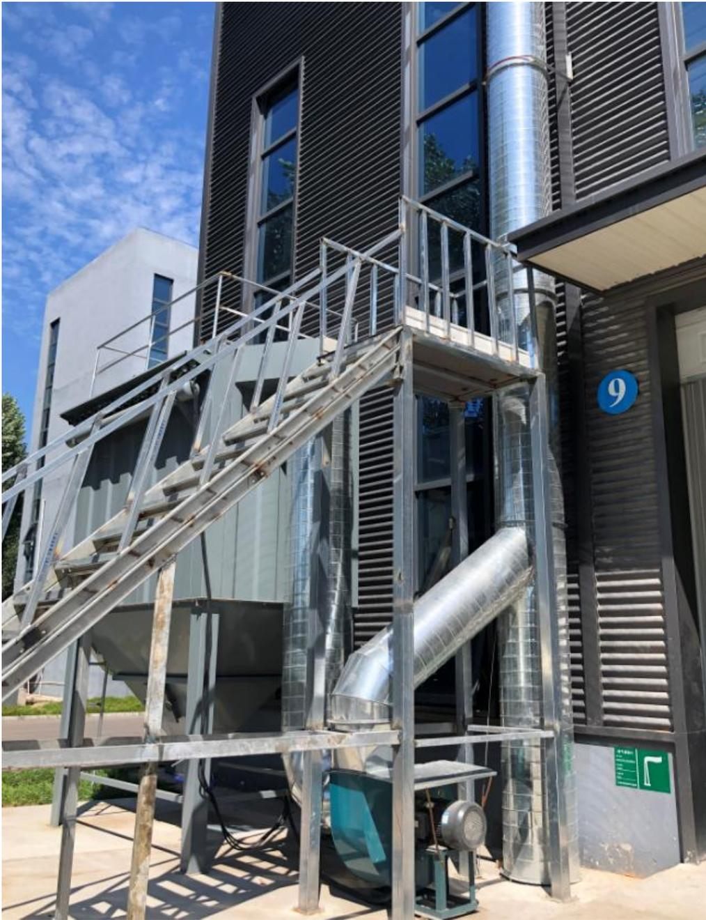
图 3-3 布袋除尘器及排气筒 P<sub>1</sub> 照片
