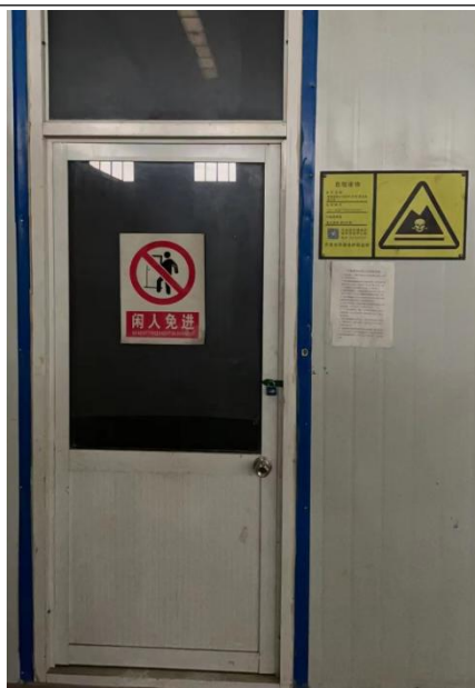
危废暂存间规范化
