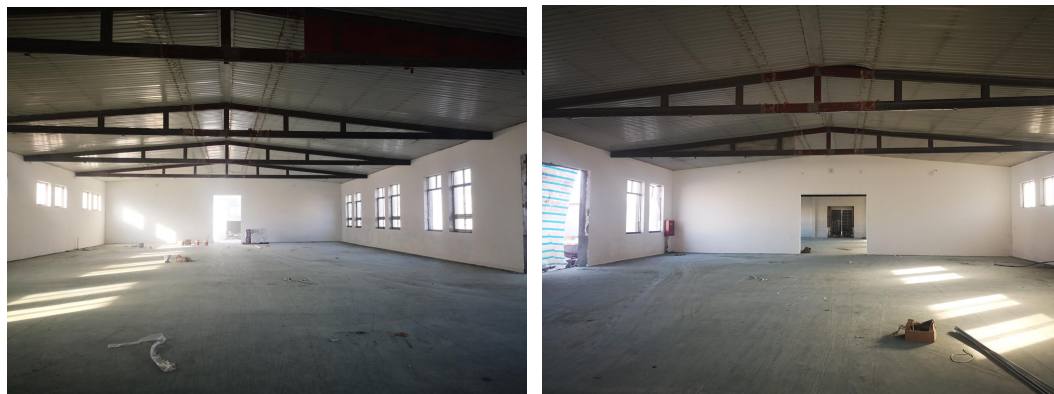
图 2-8 本项目车间内现场照片
