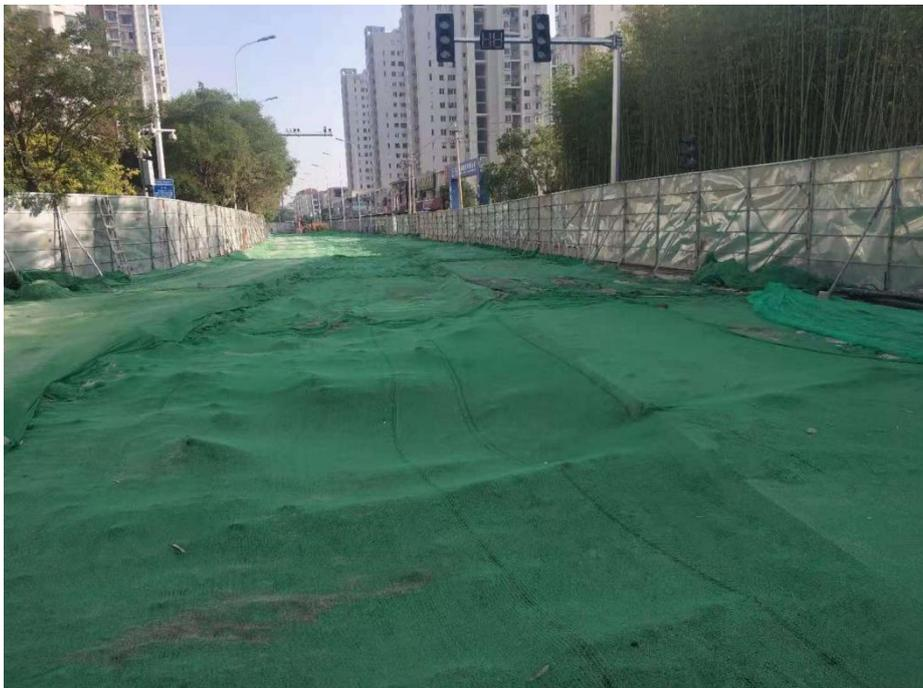
图 4-3 施工现场围挡措施
