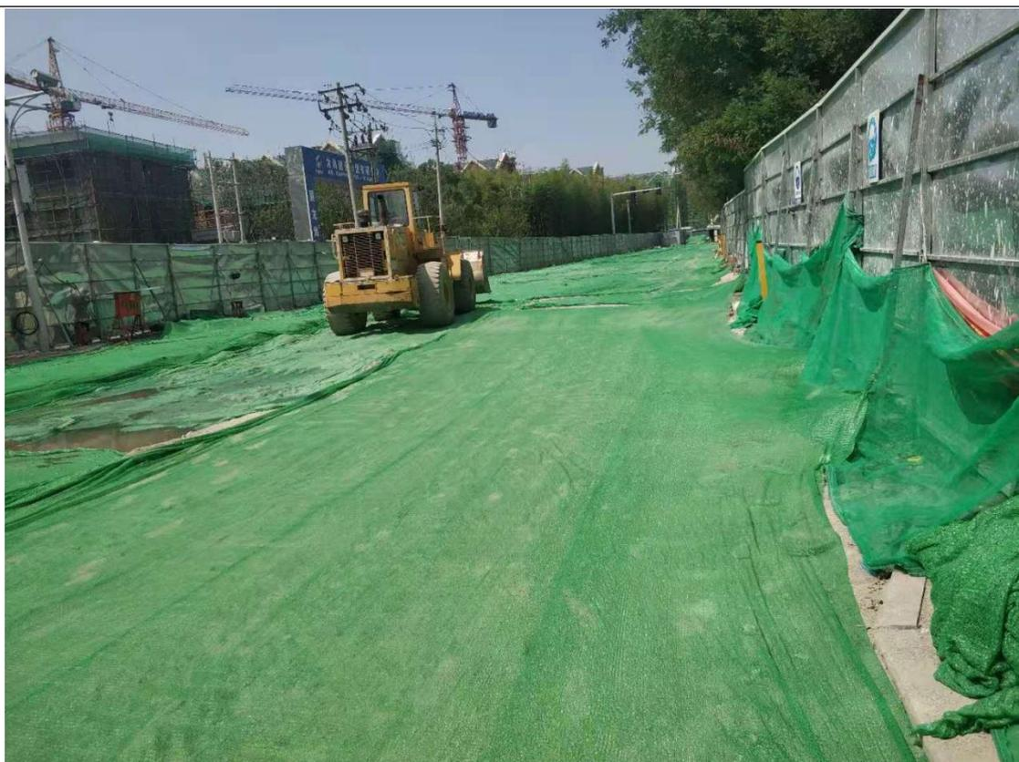
图 4-1 施工现场围挡及苫盖措施
