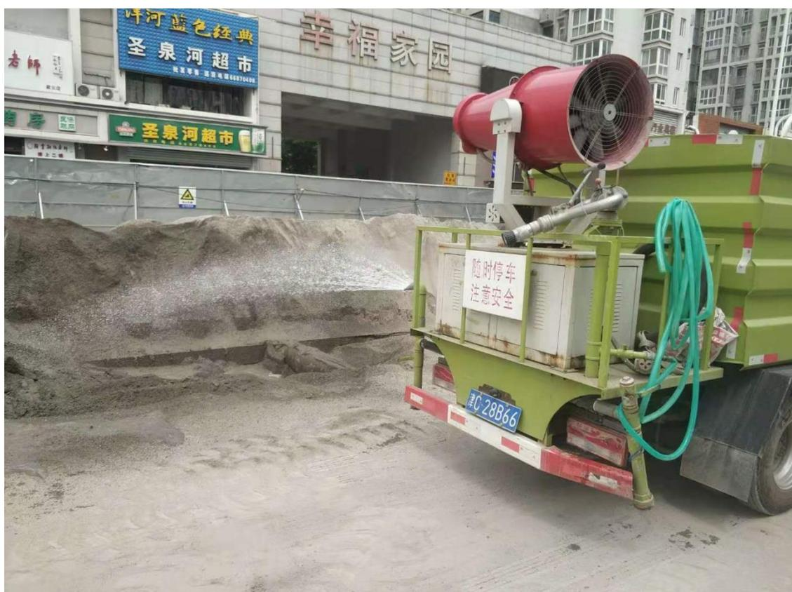
图 4-2 施工现场洒水抑尘措施
